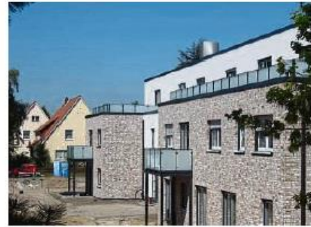
Letzte Arbeiten werden noch ausgeführt in den Wohnungen und den Außenanlagen.
